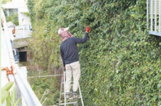
外壁のつる草もカットして見栄え良く
