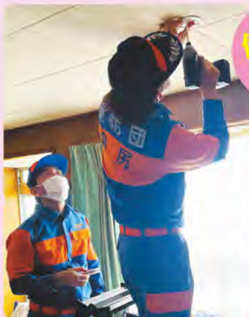
島尻消防団員による設置作業
